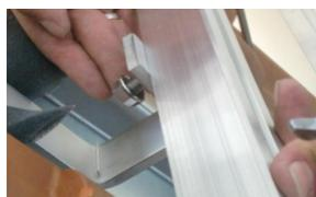
Befestigen Sie die Alu-Schienen "Light" mittels Skt.-Schraube M10x25 und Skt.-Mutter M10 mit Sperrverzahnung an die Dachhaken. (2 Profil-Schienen pro Modulreihe, in einzelnen Fällen könnte Statikbedingt bei hohen Schneelastzonen eine 3te Schiene je Modulreihe benötigt werden)
