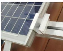
Befestigen Sie nun den vormontierten Modulhalter so an der Profilschiene, indem Sie die Skt.-Mutter in die obere Schienenführung einfädelt und den Modulhalter bis zum Modul schieben. Anschließend schieben Sie das nächste Modul, zuerst wieder von oben an die Schiene (Abrutschsicherung) und dann seitlich zum montierten Modul. Dies nun von Modul zu Modul...
