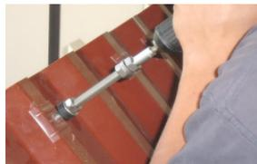
Für Alu-Unterkonstruktionen auf Wellethernit- o. Trapezblechdach, werden zur Befestigung vormontierte Stockschrauben verwendet. Drehen Sie die Stockschraube (Position lt. Plan, auf den Hochsicken o. Wellenberg) von der Seite gesehen, senkrecht zur Dachneigung in die Pfette.
