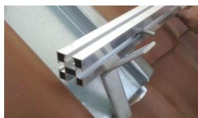
Befestigen Sie die Alu-Schienen "Profi" (in seitlicher Führung) mittels Skt.-Schraube M10x25 und Skt.-Mutter M10 mit Sperrverzahnung an die Dachhaken. (2 Profil-Schienen pro Modulreihe, in einzelnen Fällen könnte Statikbedingt eine 3te Schiene je Modulreihe benötigt werden). Die Alu-Schienen "Profi" können auch mittels der unteren Führungsschiene an die Dachhaken "oben" montiert werden (siehe Montagepunkt 4)
