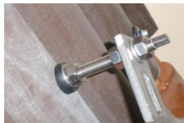
Das Adapterblech bzw. der Doppeladapter zwischen den zwei oberen Muttern und Beilagscheiben befestigen.
