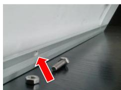
Als zusätzliche Abrutschsicherung werden bei allen Modulen, die hochkant montiert werden, zwei Skt.-Schrauben M6x20 oder M8x20 an der Unterseite des Alurahmens in den vorhandenen Bohrungen eingeführt und mittels Skt.-Mutter M6 oder M8 fixiert.
