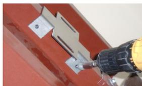
Nachdem auf dem Trapezblech die Position der Trapezschuhe gekennzeichnet wurde, können diese jeweils mit vier EJOT-Bohrschrauben befestigt werden.
