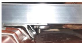
Sollte ein Schienenverbinder auf eine Hochsicke des Trapezbleches treffen, so kann ein Trapezschuh als Schienenverbinder eingesetzt werden.
