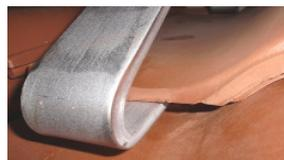
Achten Sie darauf, dass der Steg des Dachhakens nicht auf die Dachplatte gedrückt wird! In diesem Fall muss die Fussplatte entsprechend mit Holzern unterfüllt werden.
