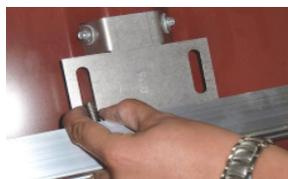
Befestigen Sie die Alu-Schienen "Light" mittels Skt.-Schraube M10x25 und Skt.-Mutter M10 mit Sperrverzahnung an den Trapezschuhen. (2 Profil-Schienen pro Modulreihe)
