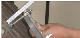
Die Adapterbleche bzw. Doppeladapter können mit den beiden Muttern in die richtige Position (Abstand zur Dacheindeckung) gebracht und fixiert werden.
