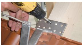
Den Dachhaken in die Senke der Dachplatte legen und mittels Spiralbohrer den Sparren vorbohren. Die Fussplatte nun mit 2x Tellerkopfschraube am Sparren festschrauben (evtl. Dachlatte seitlich unterlegen).
