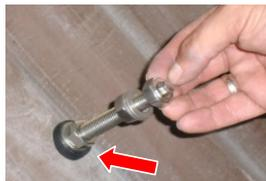
Schraube so tief einschrauben, bis der Gummi an die Dachhaut drückt und mittels Scheibe und Mutter fest fixieren.
