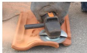
An der Unterseite der Dachplatte, die den Dachhaken abdeckt, muss mit Hilfe eines Trennschleifers eine Aussparung geschaffen werden. Bei Falzziegeleindeckung ist der untere Ziegel ebenfalls auszuspären.
