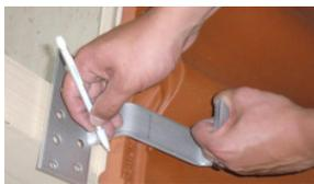
Die Dachhakenposition anhand des beigefügten Planes bestimmen und den Sparren durch entfernen der Dachplatte aufdecken.
