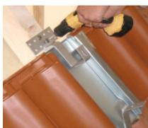
Um zu verhindern, dass durch Punktbelastung der montierten Dachhaken, die darunterliegenden Dachplatten brechen, können Metalldachplatten passend für die Dacheindeckung eingesetzt werden.
