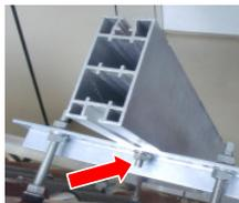
Befestigen Sie die Alu-Schienen "Profi", "Light" oder "Profi XL" (in der unteren Führungsschiene) mittels Skt.-Schraube M10x25 und Skt.-Mutter M10 mit Sperrverzahnung an den Doppeladapter. (2 Profil-Schienen pro Modulreihe)
